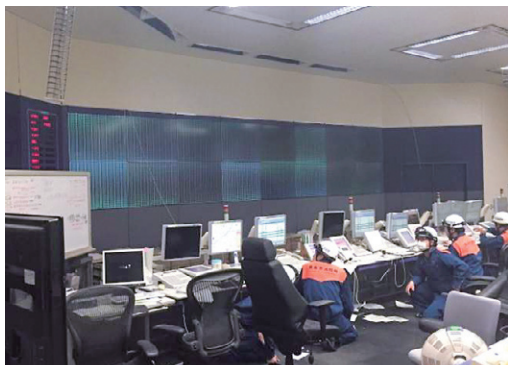
本震直後の指令管制室
